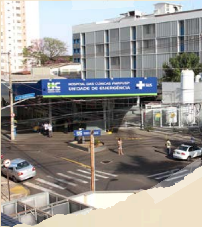
Unidade de Emergência
