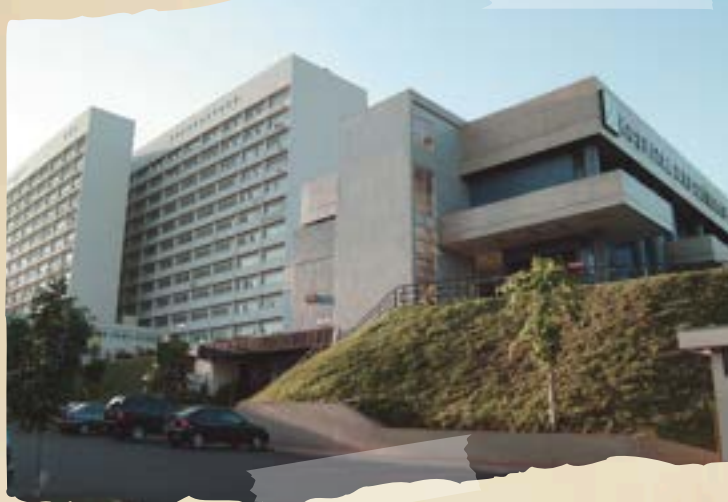
Hospital das Clínicas
