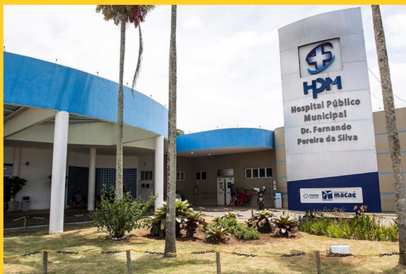
HOSPITAL PÚBLICO MUNICIPAL DE MACAÉ (HPM)
