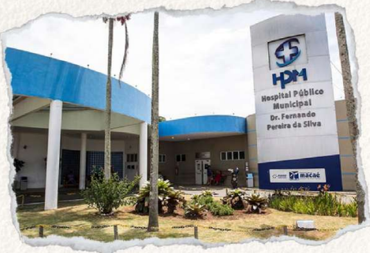
HOSPITAL PÚBLICO MUNICIPAL DE MACAÉ (HPM)
