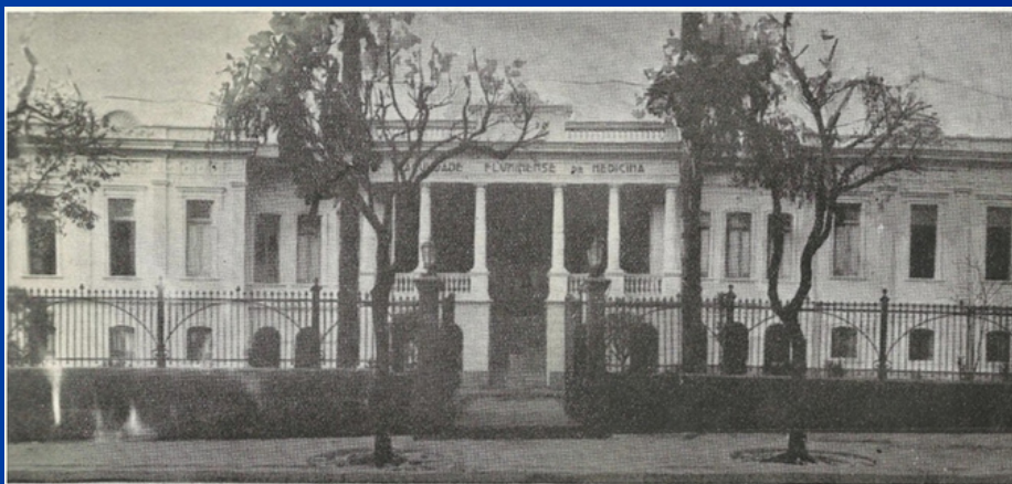
Edifício da Rua Visconde de Morais, 101
